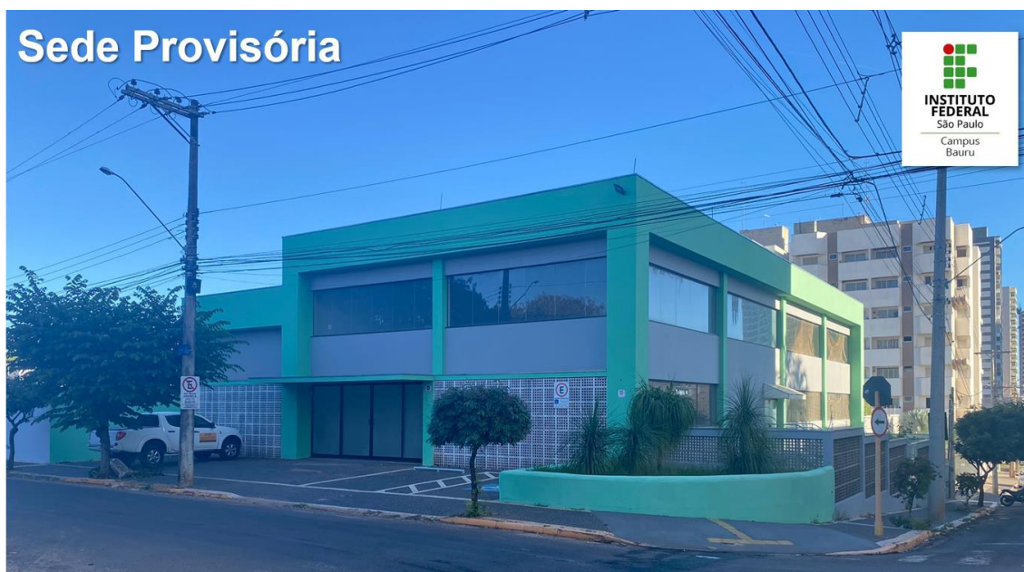
Figura 1 - Sede Provisória do IFSP Campus Bauru.
